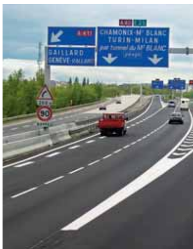
Nœud autoroutier d'Étrembières : un trafic sécurisé avec la suppression des entrecroisements.
